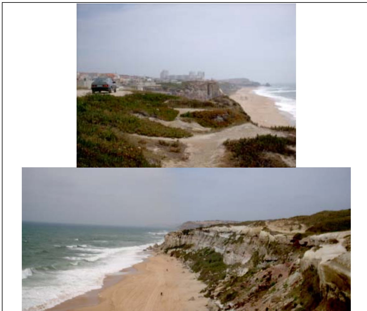
Figura 12 – Terrenos em Santa Cruz (Torres Vedras)
